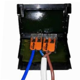
3. Mettre les connecteurs dans le boîtier de raccordement et refermer.
